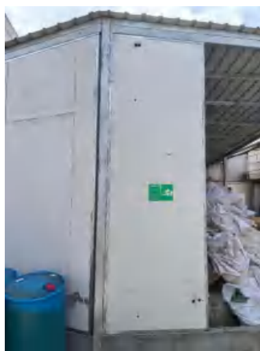
一般固废仓库建设情况
