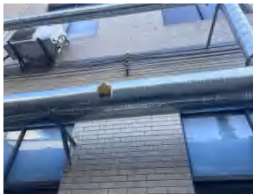
废气排气筒出口进口
