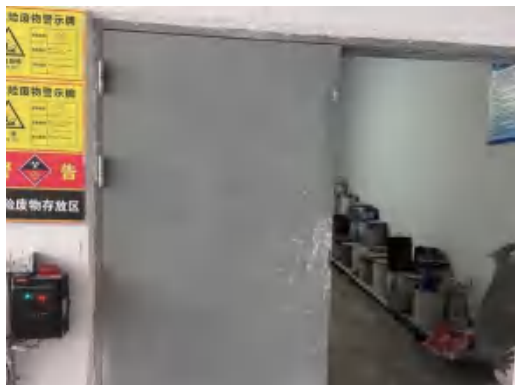
危废仓库建设情况
